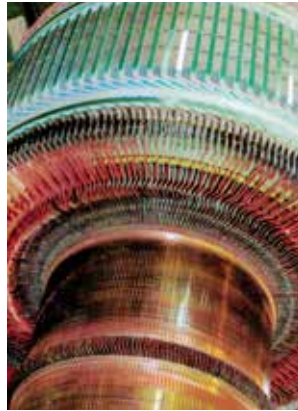
Komplett omlindning av DC-generatorer 1,5 MW till valsverk, Uddeholm.
