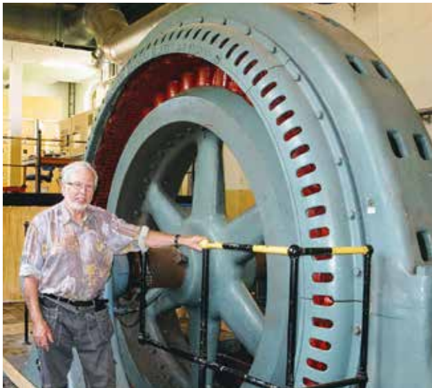
Omlindning av vattenkraftgenerator.
