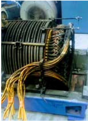
Omlindning av stator och rotor samt ny magnetplåt för släpningad motor 500 kW, LKAB.
