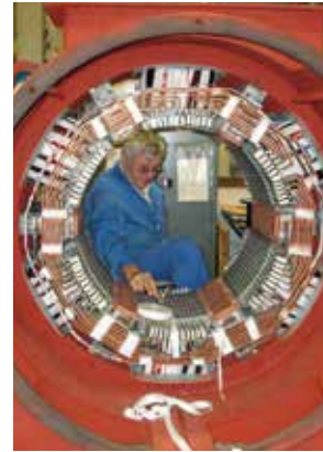
Omlindning av 1 MW DC-motor, Stora Enso.
